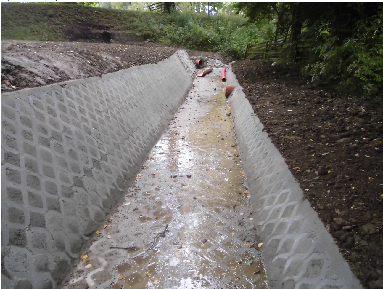
Opravená spojovací stoka
